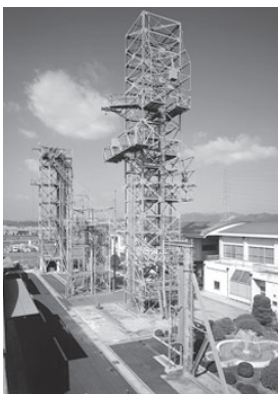
屋外試験鉄塔群
